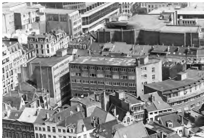
Densification des constructions en intérieur d'îlot (4) Galerie du centre
