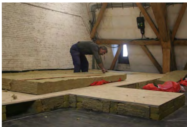
Pendant les travaux – novembre 2011
