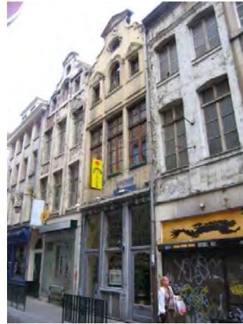
rue des Eperonniers n°s 49-51 pignon à rampants chantournés
