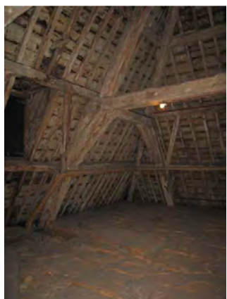
État du grenier avant les travaux de 2011
