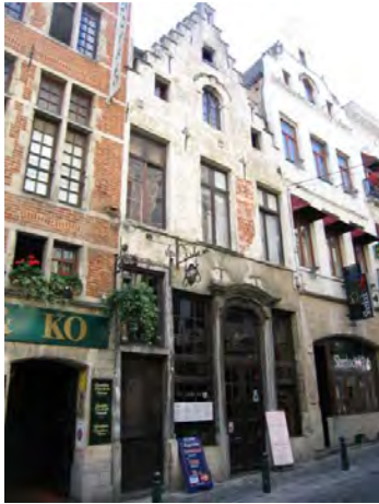
rue des Chapeliers n°s 18-20 pignon à gradins
